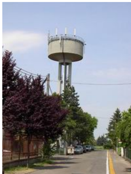
Impianto Vodafone / Wind
