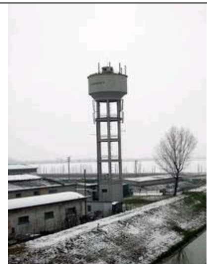
Impianto TIM / Vodafone
