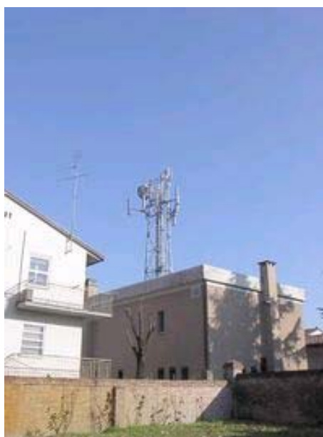
Impianto TIM / Vodafone
