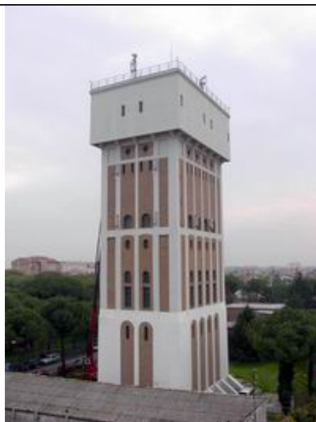
Impianto TIM / Vodafone / H3G
