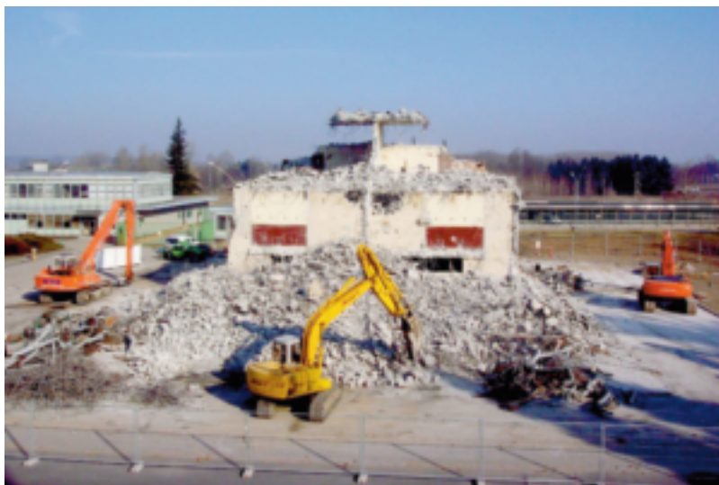
Decommissioning Trino, la demolizione delle torri di raffreddamento e l'area dopo la conclusione dei lavori
