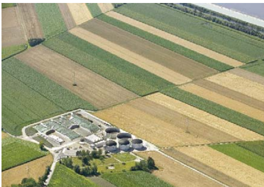
FOTO: SCHANCK BIOGAS
