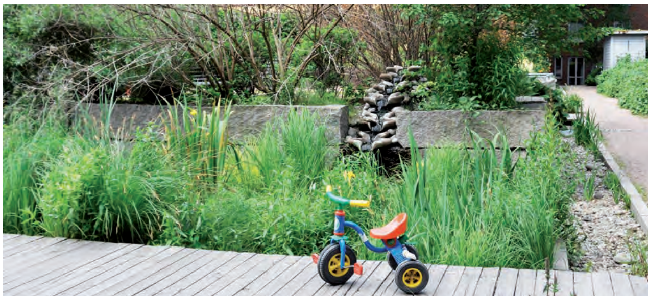
Fitodepurazione delle acque grigie ad Oslo: impianto integrato nel verde a servizio dell'edificio. (Foto: Jaime Nivala - CC)
