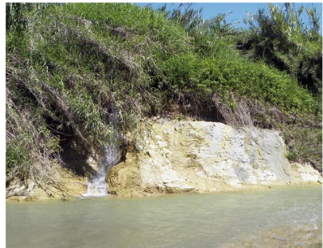
Scarico nel fiume Saline.
