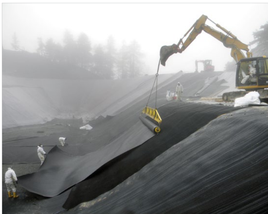
Sin di Emarèse, predisposizione del bacino di confinamento per il conferimento del materiale sterile contaminato: isolamento del fondo e delle scarpate laterali.
