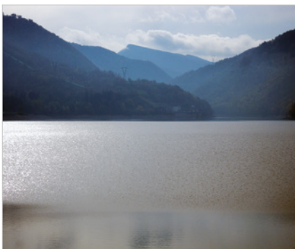
Diga di Suviana Altitudine: 450 m slm Uso: idroelettrico, idropotabile Altezza: 96 m Sviluppo sul coronamento: 225 m Capacità: 43,85 Mm 3
