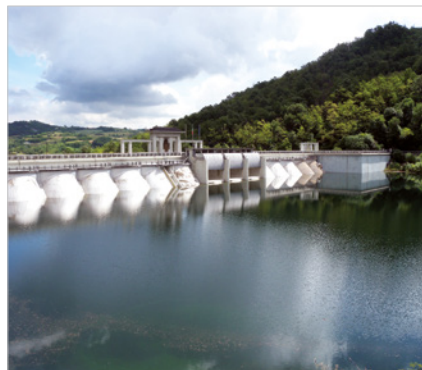
Diga del Molato (lago di Trebecco) Altitudine: 359 m slm Uso: irriguo, idroelettrico Altezza: 55 m Sviluppo sul coronamento: 335 m Capacità: 7,6 Mm 3
