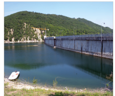
Diga di Mignano Altitudine: 341 m slm Uso: irriguo, idroelettrico, idropotabile Altezza: 51 m Sviluppo sul coronamento: 341 m Capacità: 10,2 Mm 3
