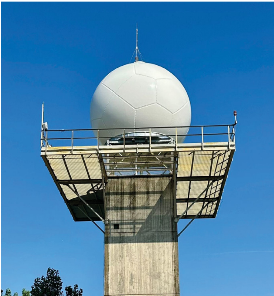
1 Il radar meteo Arpa di San Pietro Capofiume (Molinella, BO), recentemente rinnovato.
