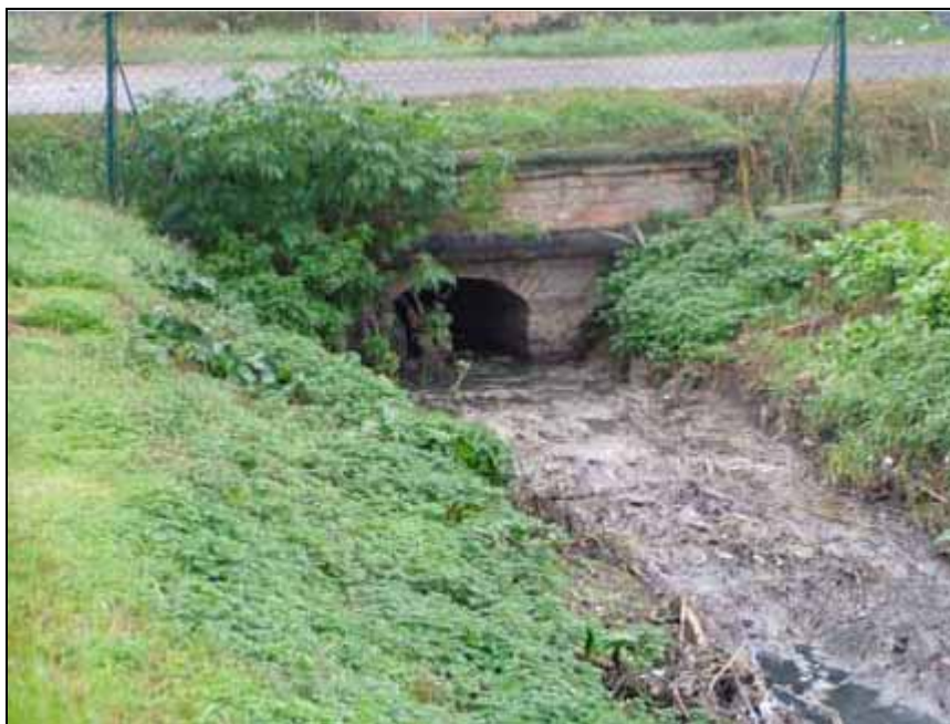
Fig. 12 Sacerno: uscita dal tratto tombato
