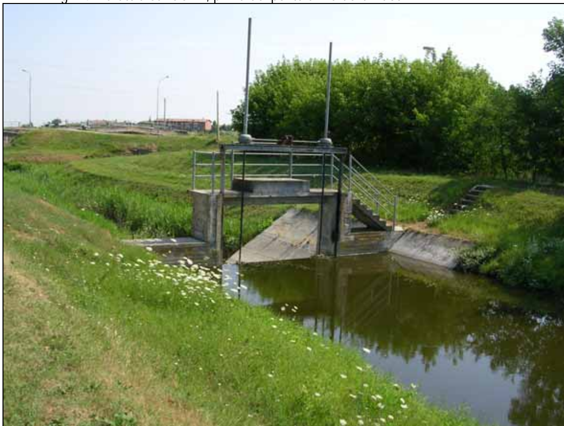
Fig. 14: Paratoia sul CCAB, prima del ponte di via della Pace
