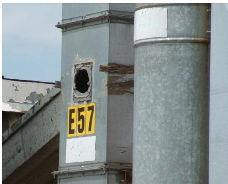
Fig. 6: emissione dotata di punto di campionamento privo di bocchello: bocchello distaccato dalle pareti del camino.
