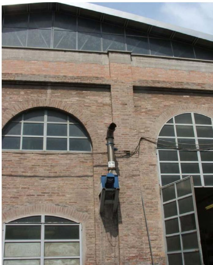
Fig. 9: posizione non corretta della bocca del camino: bocca posta sulla parete laterale dell'edificio aziendale.
