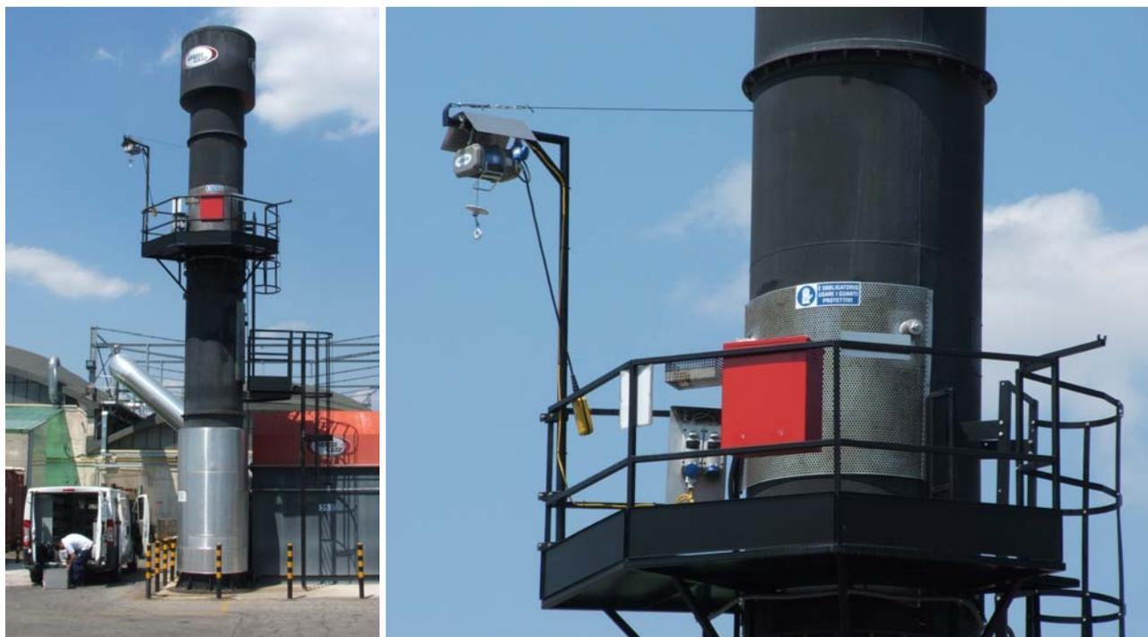
Fig. 17: esempio di corretta postazione di lavoro a servizio di punto di prelievo posto in quota.
