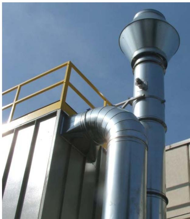
Fig. 20: piattaforma di lavoro non corretta: punto di campionamento con 2 bocchelli di prelievo posizionati a 90° e piattaforma di lavoro rettangolare.
