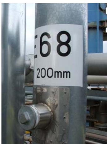
Fig. 4: idoneo bocchello di campionamento.
