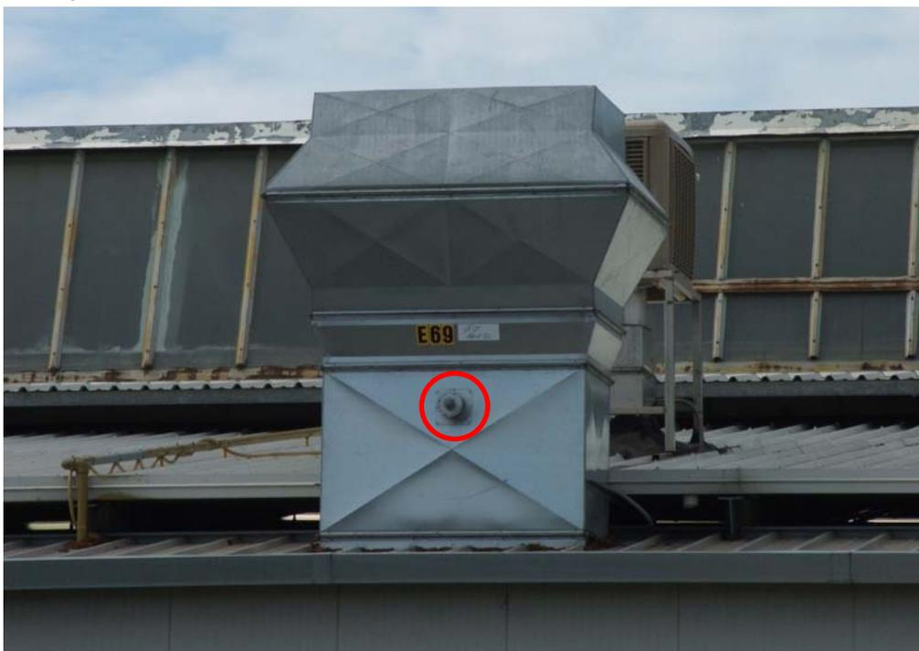
Fig. 1: emissione dotata di punto di campionamento posto in posizione non corretta: tratto rettilineo a valle del bocchello di campionamento troppo breve.
