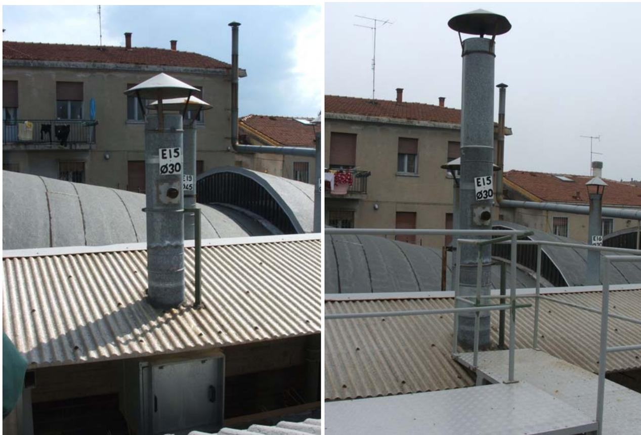
Fig. 22: percorso di accesso in quota al punto di prelievo: nella prima immagine, postazione di lavoro e percorso di accesso assente; nella seconda immagine, corretta disposizione.
