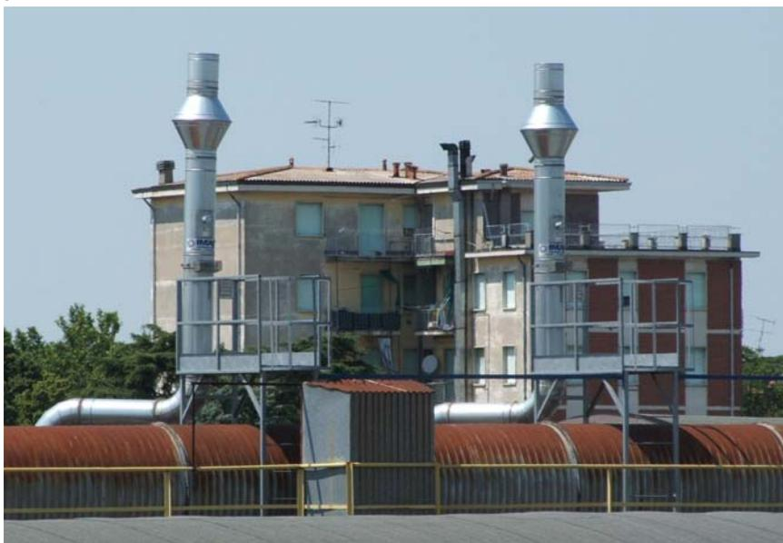
Fig. 10: posizione corretta della bocca del camino rispetto agli edifici.
