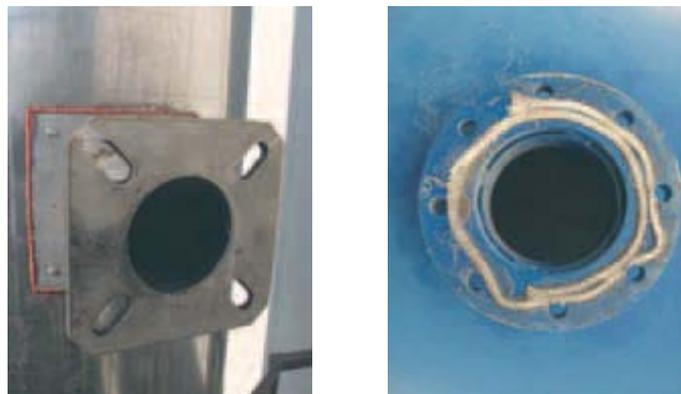
Fig. 8: esempi di tipologia di bocchello di campionamento a supporto delle sonde utilizzate per il campionamento di microinquinanti organici.
