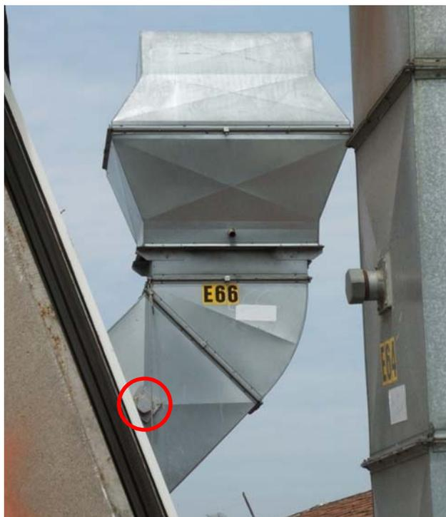
Fig. 3: emissione dotata di punto di campionamento posto in posizione non corretta: tratto rettilineo a valle del bocchello di campionamento troppo breve per la presenza di tratto curvo e con variazione delle dimensioni.
