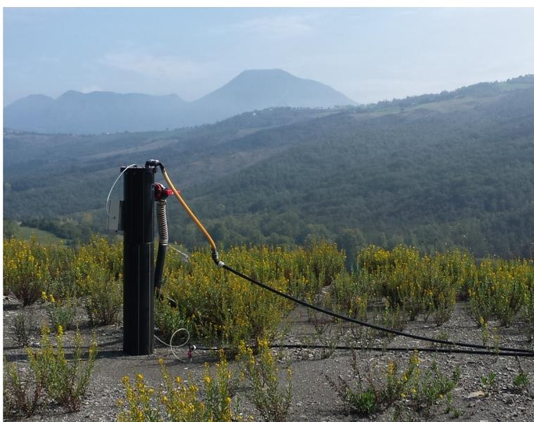
*Vista di un pozzo per l'estrazione del biogas*
