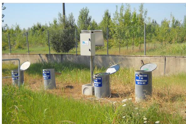
Vista dei piezometri P5A-P5B-P5C-P5D
