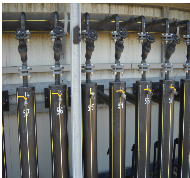
Particolare un pozzo per l'aspirazione e di una sottostazione per la regolazione del biogas del biogas
