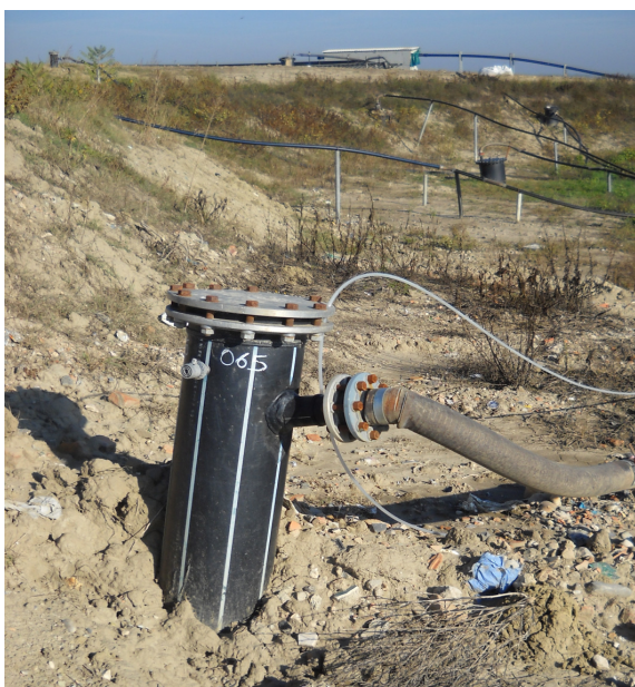
Particolare un pozzo per l'aspirazione e di una sottostazione per la regolazione del biogas del biogas
