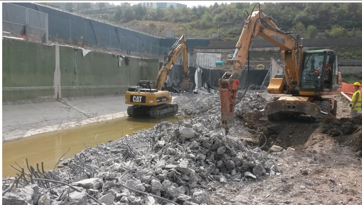
Foto n.8: Lavorazioni di demolizione presso cantiere vasche V1 - V2
