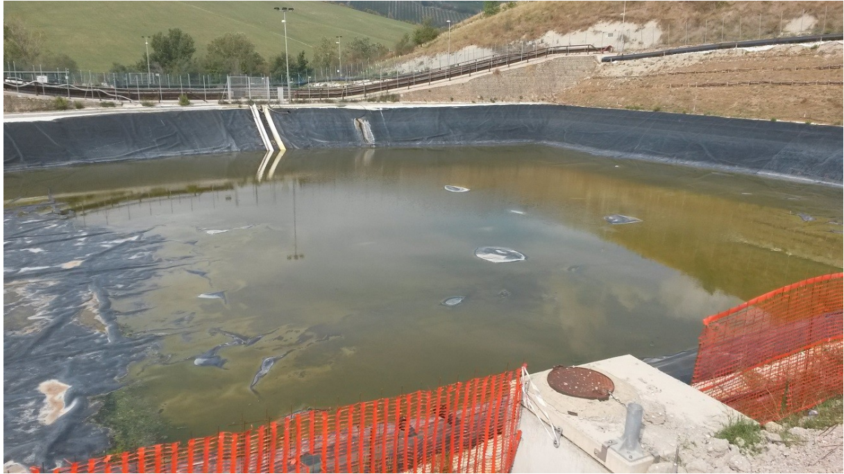
Foto n.9: Vasca V3 con acqua meteorica cantiere vasche V1 - V2
