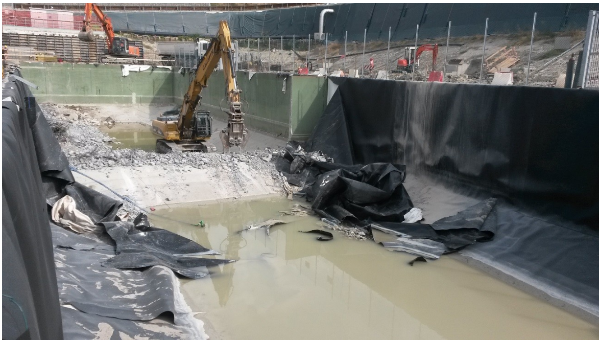
Foto n.6: Lavorazioni di demolizione presso cantiere vasche V1 - V2
