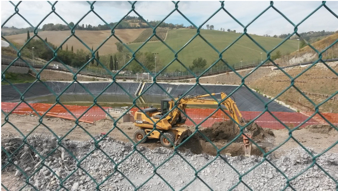
Foto n.5: Lavorazioni di scavo presso cantiere vasche V1 - V2
