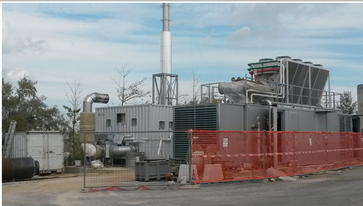
Foto n.11: Vista cantiere installazione nuovo motore per recupero energetico del biogas
