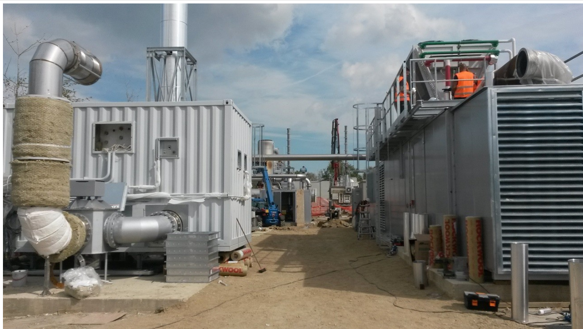
Foto n.12: Vista cantiere installazione nuovo motore per recupero energetico del biogas
