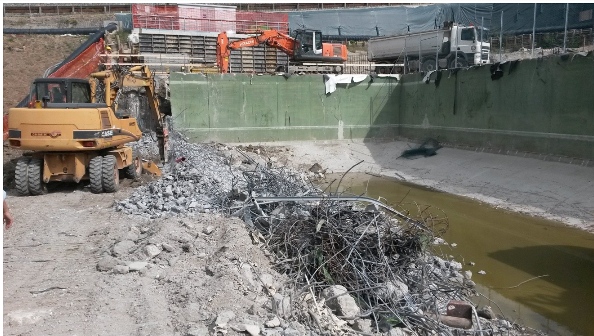
Foto n.7: Lavorazioni di demolizione presso cantiere vasche V1 - V2
