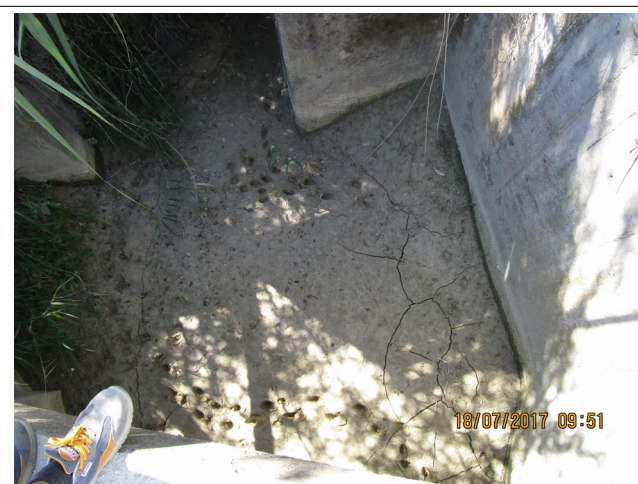
Alveo rio presso ponte via Rio Rondinella
