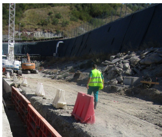
Vista lavori in corso rimozione vasche V1 e V2
