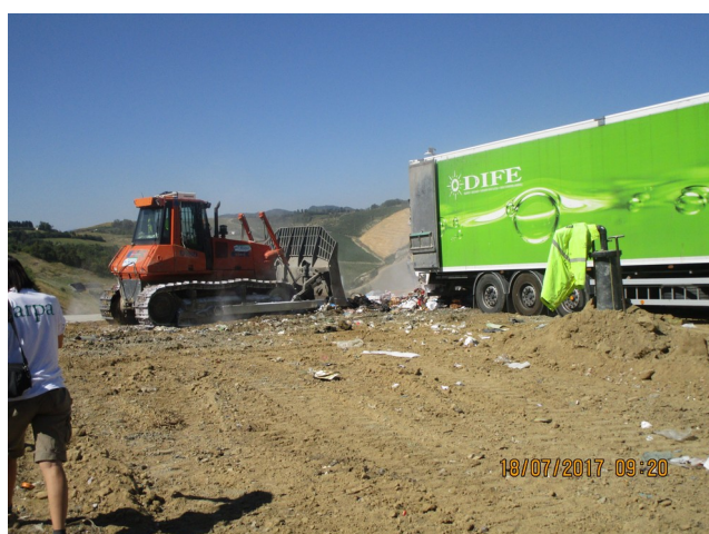
Fronte di abbancamento rifiuti nel 3° lotto
