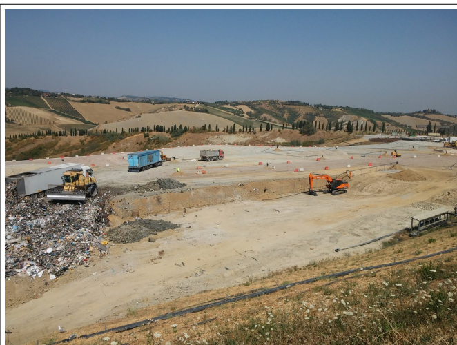
Fronte di abbancamento rifiuti nel 3° lotto
