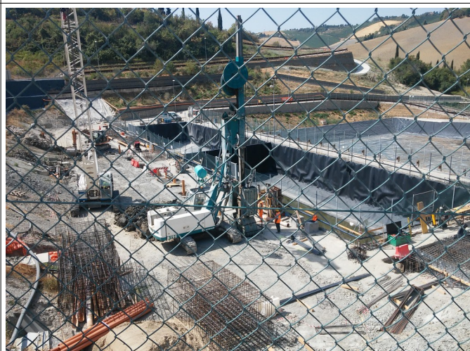
Vista area cantiere rimozione vasche V1 e V2
