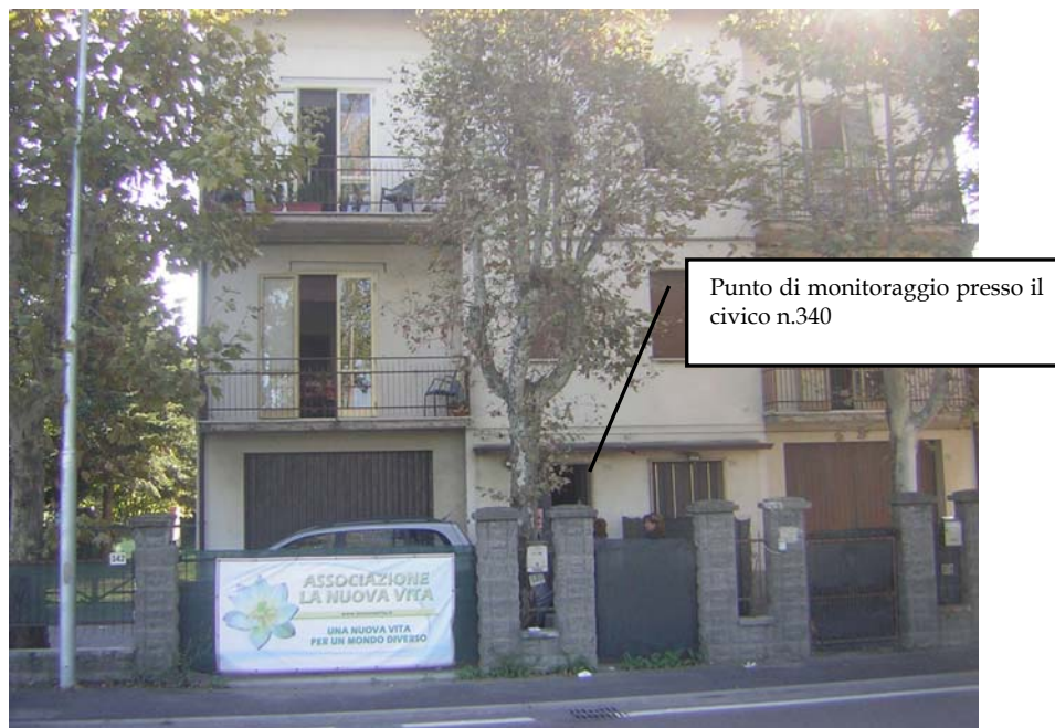
Figura 2 – Edificio interessato al monitoraggio acustico
