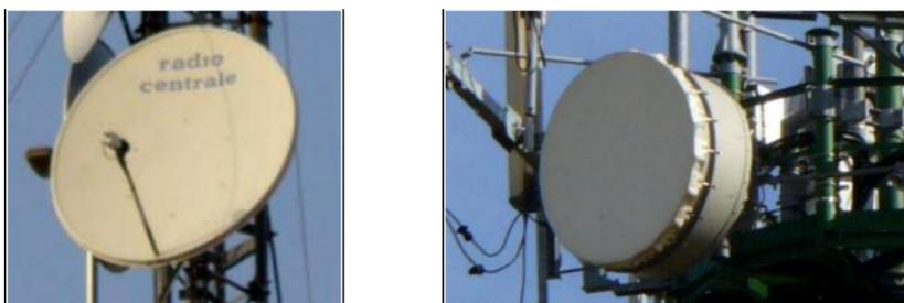
Figura 9 : Esempio di ponte radio di antenna radio e di ponte radio di SRB
