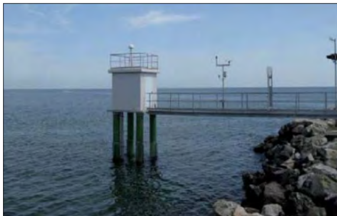
FIGURA 7. La stazione mareografica di Porto Garibaldi collocata in prossimità della testa del molo Nord del porto canale.
