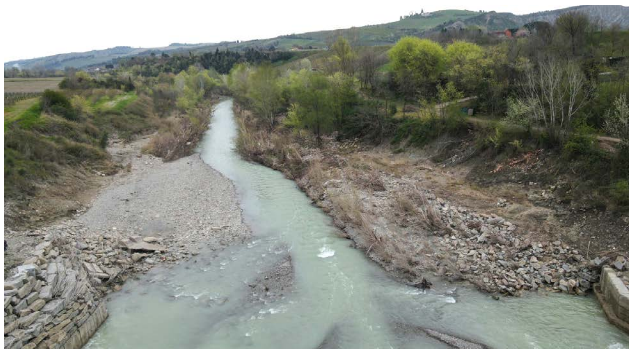
Fig. 15 - Foto presso Diga di Codrignano
