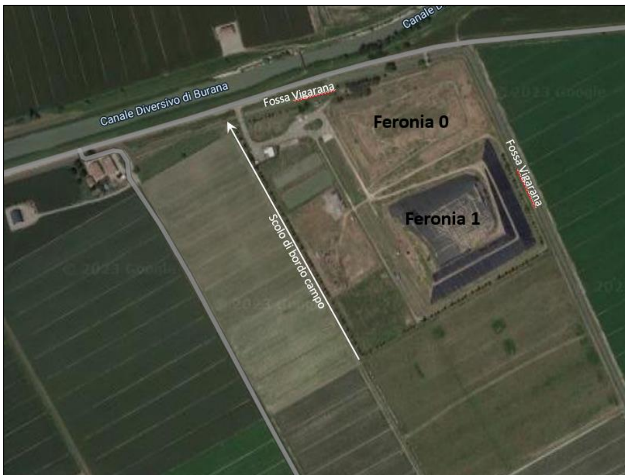
Figura 1.10: Canali e drenaggio acque superficiali limitrofi all'impianto di discarica.
