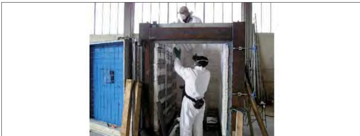
Foto 2 - Montaggio moduli in FCR a coibentazione del forno
