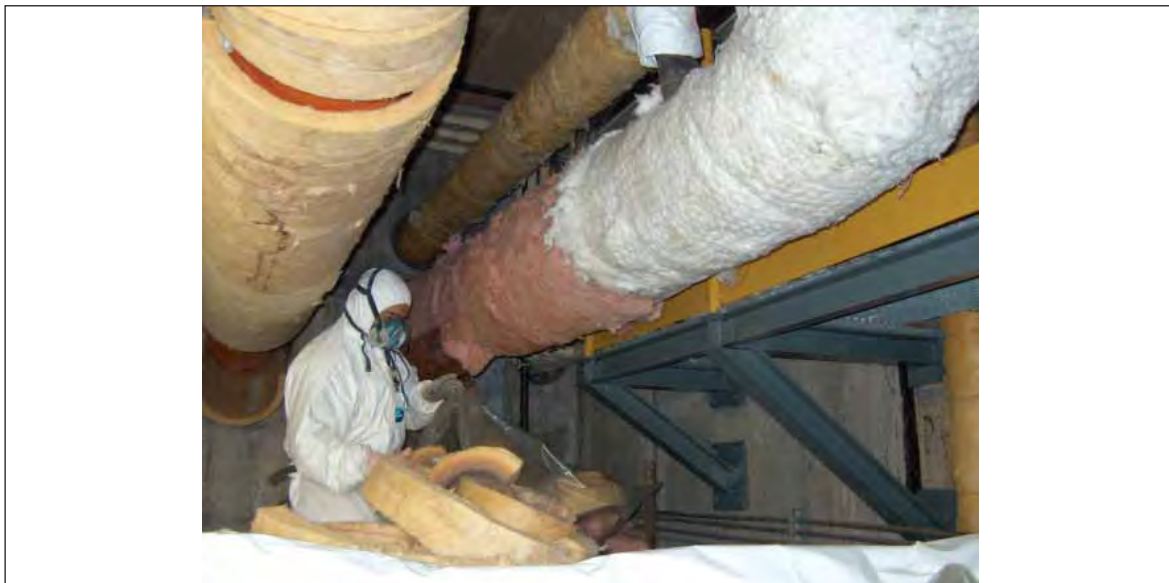
Foto 7 - Rimozione materiali fibrosi presso centrale termoelettrica
