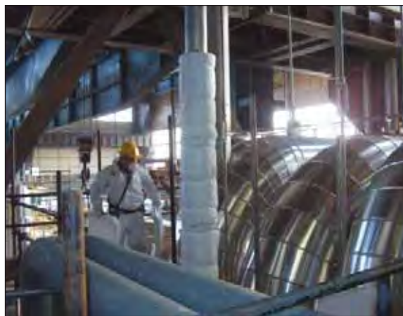
Foto 14 - Coibentazione tubazione verticale e di piccolo diametro
