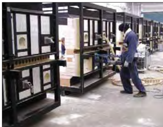
Foto 16 - Fase di installazione forno
