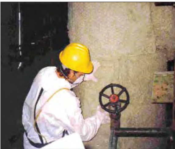
Foto 13 - Operazioni di finitura coibentazione
