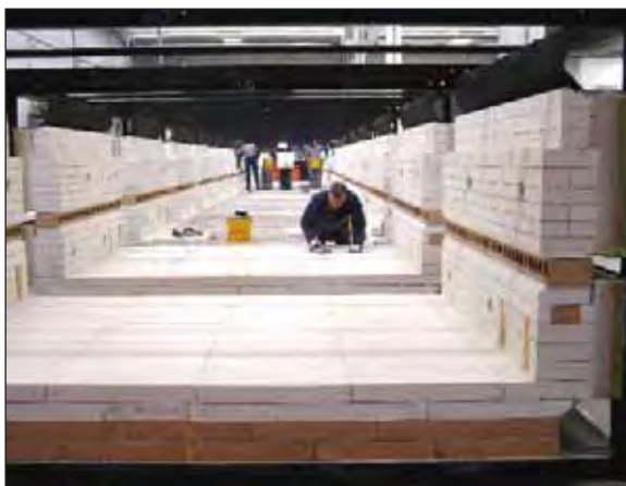
Foto 15 - Costruzione forno
