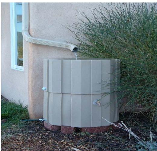
Un sistema di collettamento da pluviale per la raccolta della pioggia (da [www.aridsolutionsinc.com](http://www.aridsolutionsinc.com))
