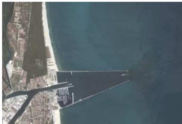
Figura 4 - Estensione delle dighe foranee del Porto Canale di Ravenna
