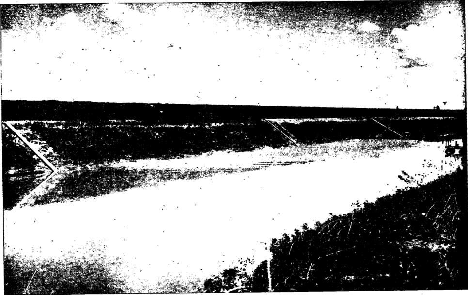
Fig. 5 - Tratto del Reno (a valle di Passo del Gallo) in cui si eseguono le misure. Idrometri in sponda sinistra per il rilievo delle pendenze superficiali.
