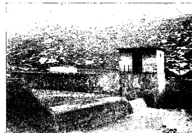
« Rio Cella a S. Benedetto del Querceto » Stazione registratrice e per misure di portata.
