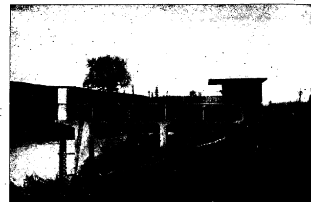
Potenza a Cannuciaro - Idrometrografo e stazione per misure di portata.
