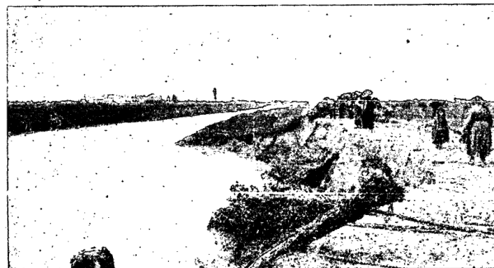
Fiume Savio - Franamento argine a monte abitato di Savio
