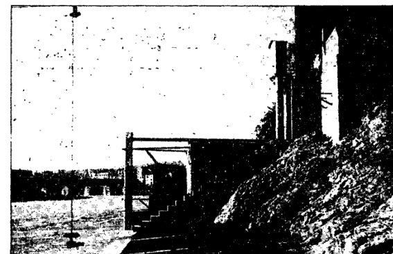
Reno a Casalecchio - Idrometrografo e stazione per misure di portata.
