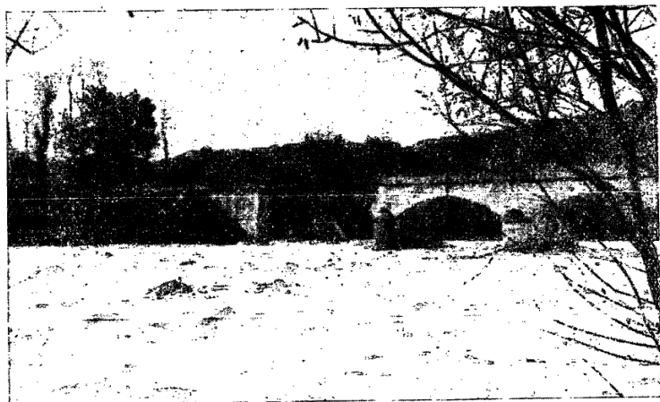
Fiume Esino a Pianello - Cedimento della spalla destra e rottura di un arco del ponte sull'Esino
