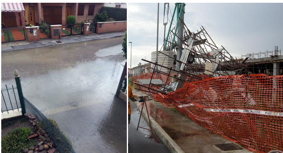
Figura 14: a sinistra: gli allagamenti a Portomaggiore (FE), da Il Resto del Carlino; a destra: il ponteggio caduto ad Argenta (FE), da La Nuova Ferrara.
