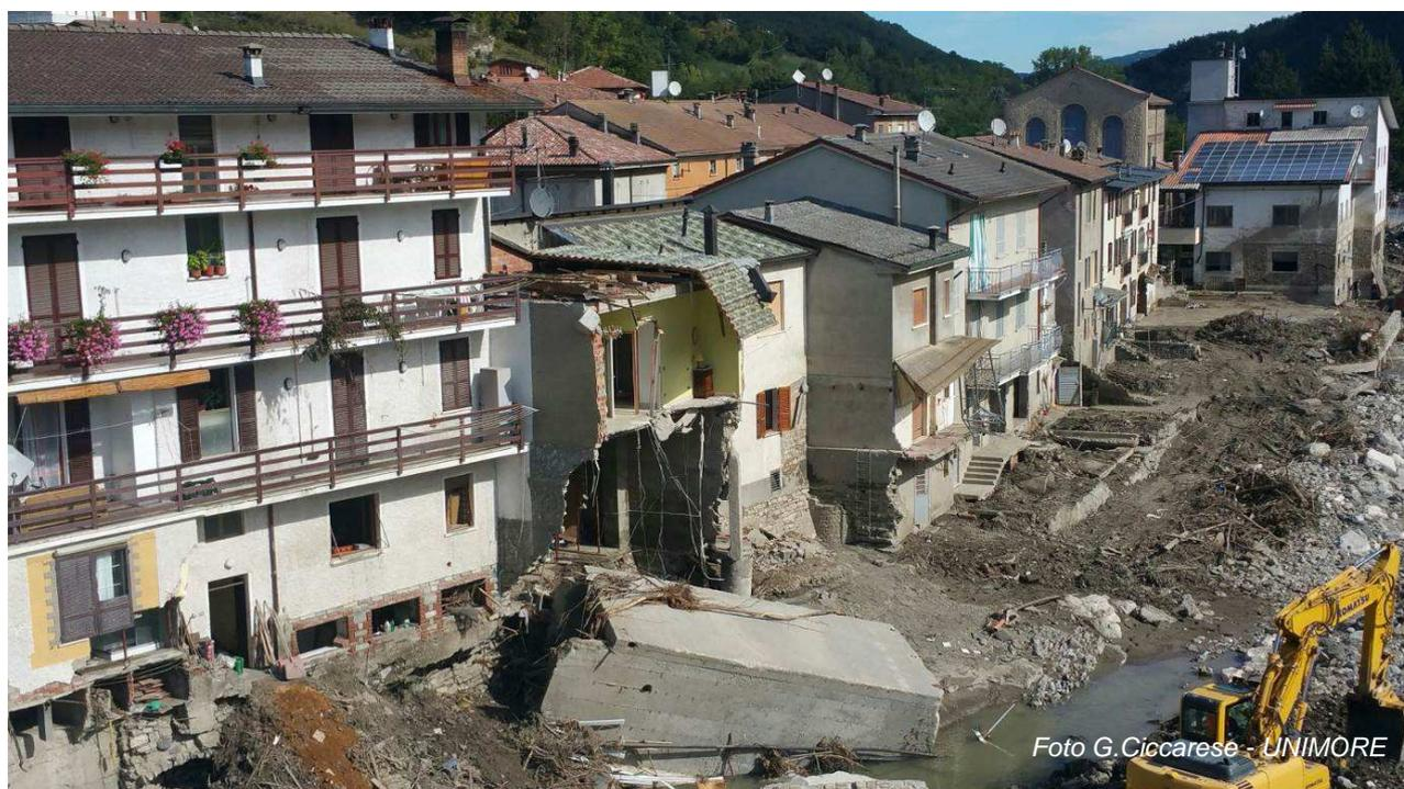
*Figura 33: Le case dell'abitato di Farini, investite dalla piena del Nure. Si notano le abitazioni e le difese spondali parzialmente distrutte e in primo piano lo scatolare dell'attraversamento di un torrente in sinistra della strada comunale Alta val Nure, trascinato a valle.*
