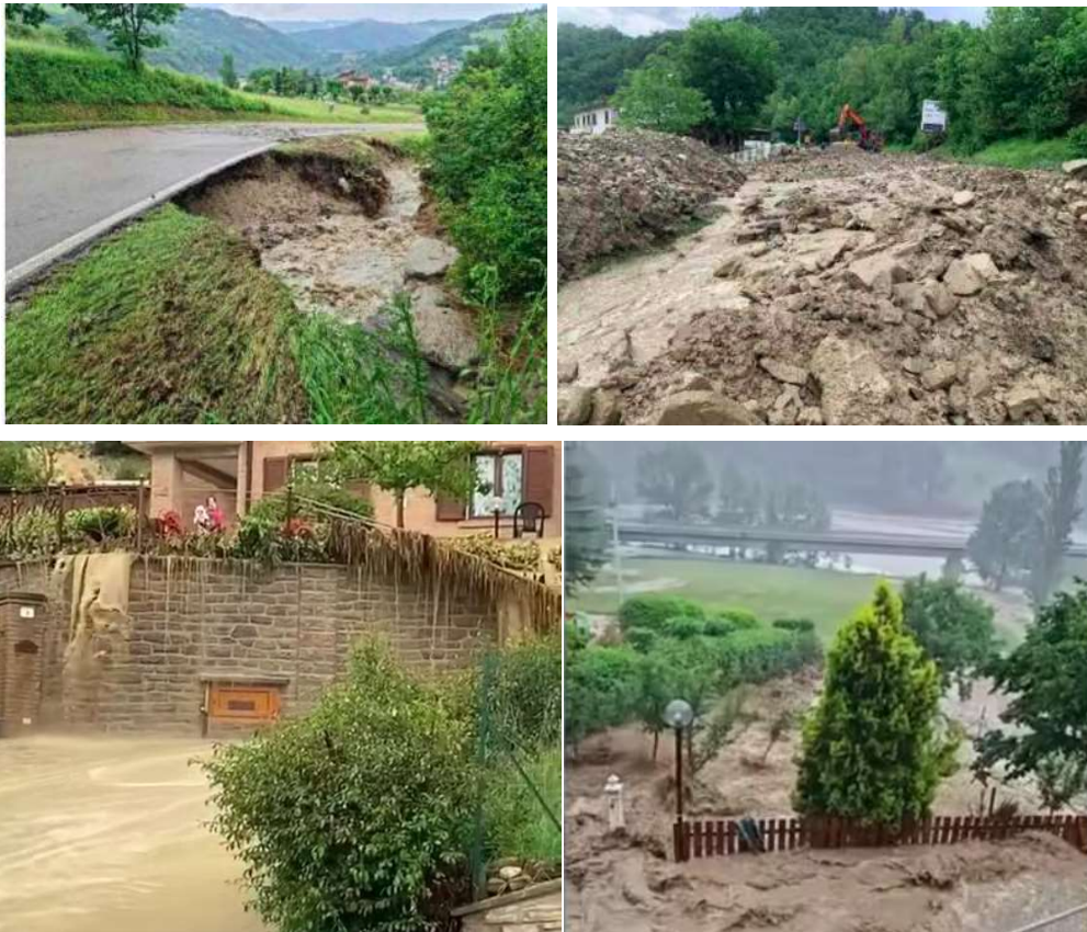
Figura 31: Smottamento a sinistra e fiume di fango a destra in alto a Baiso (RE) il 4 giugno (fonte: Resto del Carlino di Reggio), allagamento a Baiso (RE) a sinistra (fonte: istantanea dal video di Mattia Pellegrino tramite pagina Facebook Emilia Romagna Meteo) e fiume di fango a Ponte Secchia (RE) a destra (fonte: istantanee dal video della pagina web di Gazzetta di Reggio) in basso, il 4 giugno.
