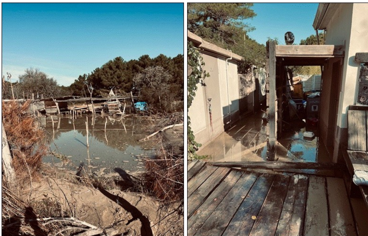
Figura 15: esempio danni Porto Corsini - bagno Que Vida (Fonte: ARSTPC - UT RA).
