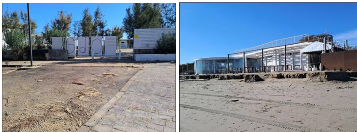
Figura 17: dettaglio Lido Adriano a sin Panoramica e dettaglio erosione arenile presso il bagno Amarissimo (Lido Adriano sud) (Fonte: AGSS).
