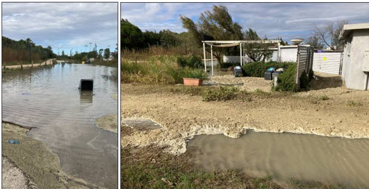
Figura 16: esempio danni Marina di Ravenna lungo V.le delle Nazioni, zona Big Mama (Fonte: ARSTPC - UT RA).
