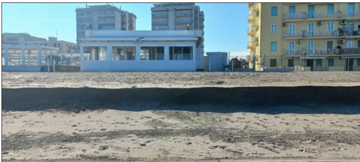
Figura 12:: Lido di Pomposa centro, Bagno Pomposa, bassa marea -0,25 m difesa (Fonte: ARSTPC-UT FE).
