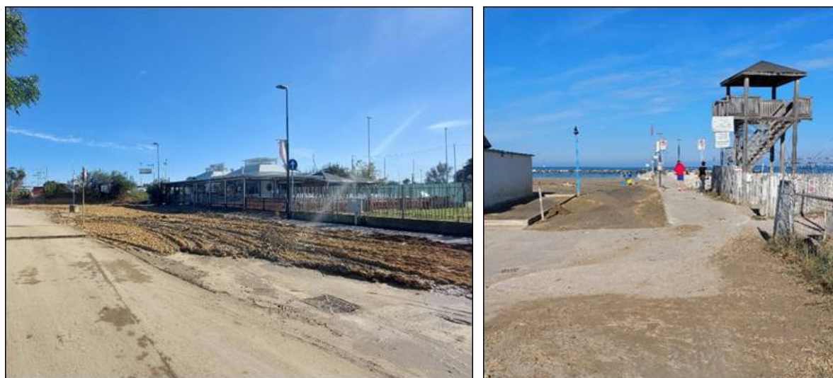
Figura 23: dettaglio danni da ingressione marina zona giardini Don Guanella a Gatteo (Fonte: AGSS).
