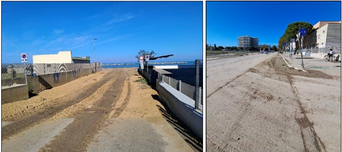
Figura 20: dettaglio ingressione marina lungomare Valverde (Fonte: AGSS).
