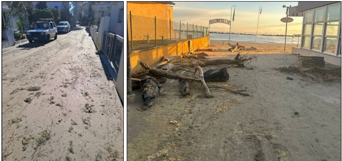
Figura 24: dettaglio ingressione marina via Dante (sinistra) e via Orsa Minore (destra) a san Mauro Mare (Fonte: AGSS e ARSTPC - UT FC).
