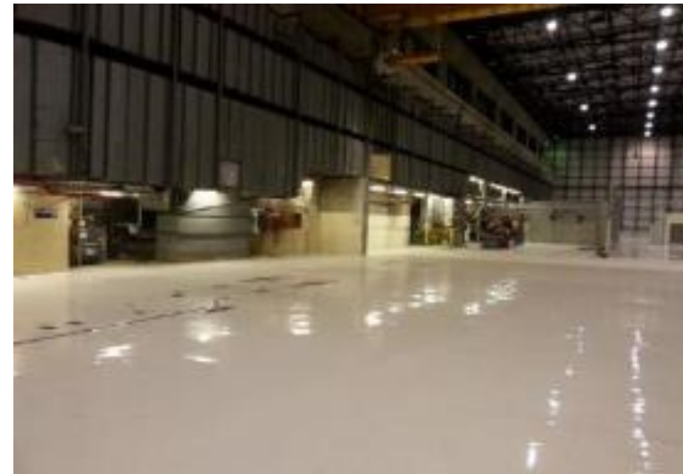
SGM al termine della rimozione carroponte e rifacimento pavimentazione (2015)
