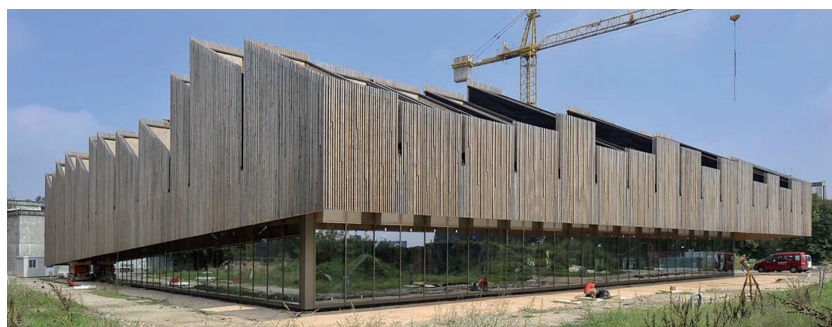
» Cantiere della nuova sede Arpa di Ferrara, Progetto studio MCA e Tecnopolis spa, foto di Moreno Maggi
